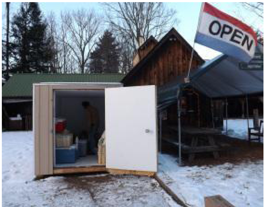
Kho lạnh sử dụng CoolBot và máy điều hòa.
