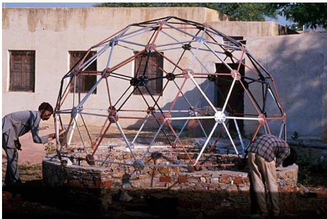
Ngôi trường gồm những kiến trúc hình mái vòm chắc chắn do dân làng tự làm từ kim loại phế liệu.
