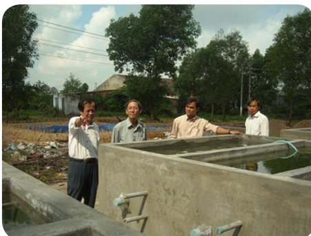
Tiến hành giám sát quá trình ứng dụng công nghệ sinh thái với thực vật bậc cao để xử lý nước thải chăn nuôi bò sữa và heo
